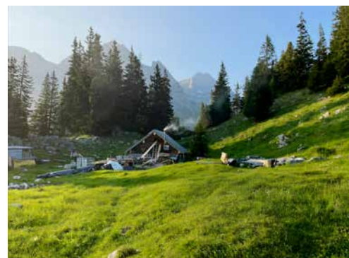
Alp Gulmen – Neusanierte Hirtenhütte
