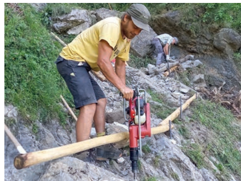
Instandstellung des zerstörten Schaftriebweges Waneloch
