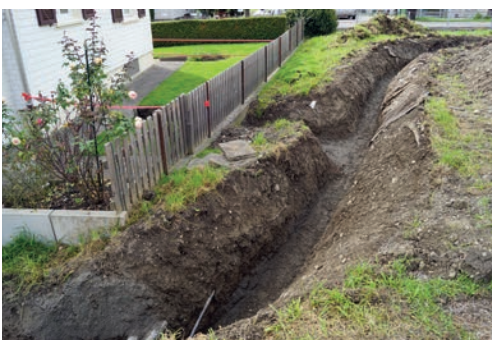
Das Fernwärmenetz wurde um 250 m erweitert
