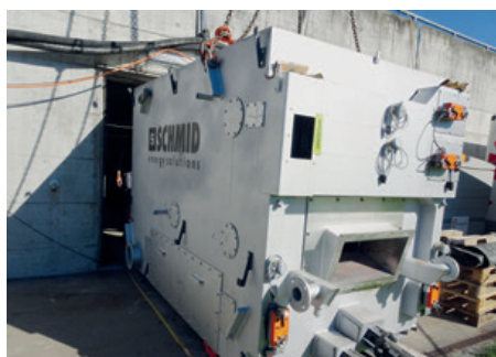
Die Kessel passen durch die vorhandene Öffnung
