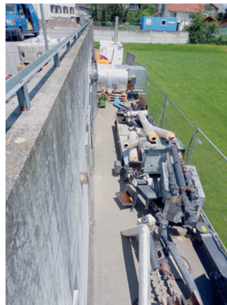
Die alte Anlage wurde demontiert und in Einzelteile zerlegt
