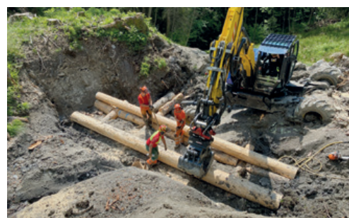
Erstellung einer Holzkastensperre
