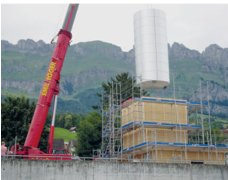
Anlieferung des Pufferspeichers per Sondertransport
