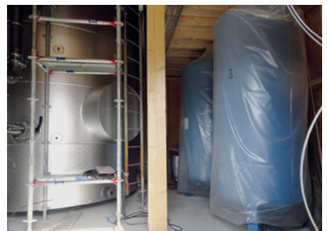
Der Speicher und die zwei Expansionsgefäße
