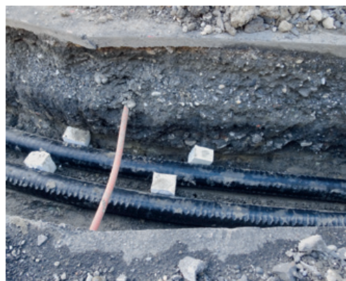
Einbau von Fernwärmeleitungen
