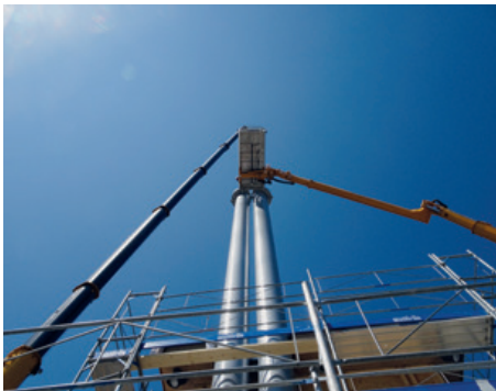
Präzision bei der Montage der Kamine
