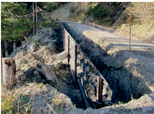
Einbau von Pfahlwänden bei der Schwendi-strasse
