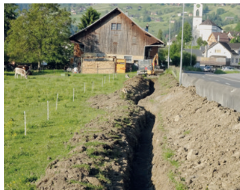
Grabarbeiten für den neuen Strang Nord
