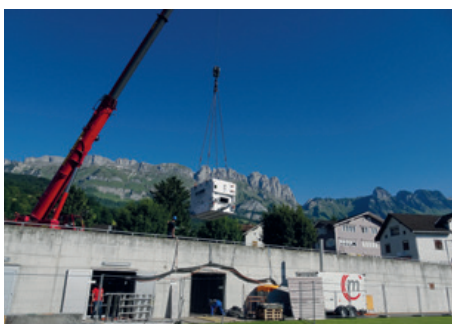
Die Heizkessel werden ins Untergeschoss gehievt
