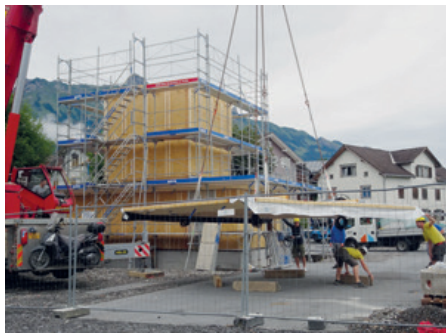
Das Dach wird vorübergehend entfernt
